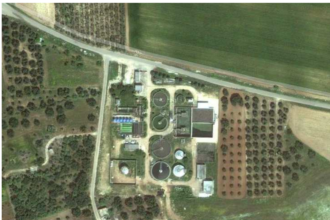
Figura 13: immagine dall'alto dell'impianto di depurazione consortile (Fonte:Google Earth)
